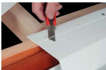
С помощью ножа сделать прорезь 10 см сквозь антикапиллярное рифление. Наложить две секции без склеивания, учитывая преобладающий ветер. Совместить 2 овальных отверстия и скрепить профили гвоздями.
