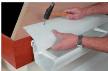
Капельник крепится на рейке. Использовать гвозди с крупной головкой для крепления капельника через овальные отверстия. Расстояние между гвоздями должно быть одинаковым и составлять макс. 50 см. Капельник необходимо установить в профиль хотя бы на 15 мм, в зависимости от модели водосточного желоба.
